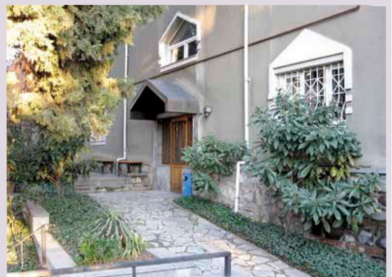
Вход в здание Дома Зальтета
