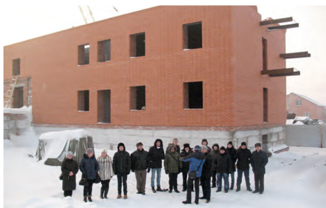
Baustelle des zukünftigen Kirchenkomplexes im Januar 2016
