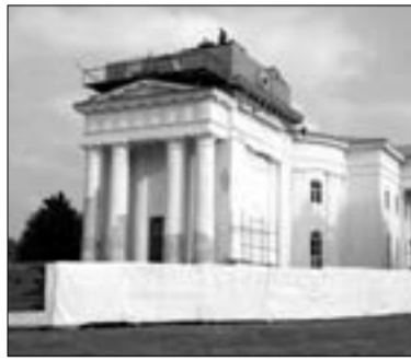
РЕСТАВИРУЕМАЯ ЦЕРКОВЬ В МАРКСЕ. ВОЗВЕДЕНИЕ БАШНИ
