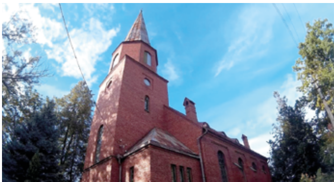
Die lutherische St.-Petri-Kirche in Petschory
