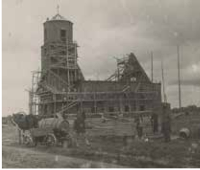
Церковь св. Петра в ходе строительства в 1920-е годы.
