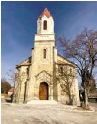
Die Erlöserkirche in Assureti nach der Renovierung
