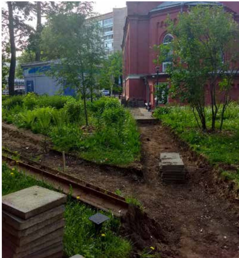
Подготовка дорожек будущего сквера.
