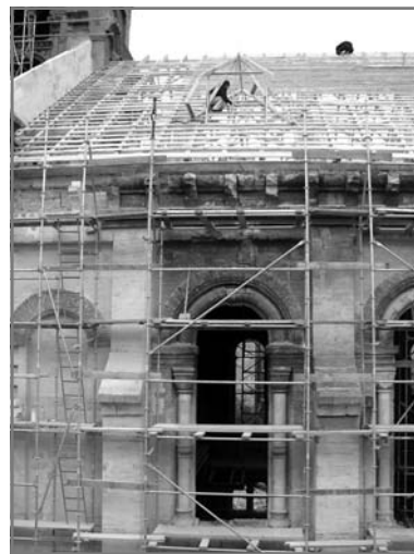
Кровля церкви св. Павла скоро будет накрываться черепицей!
