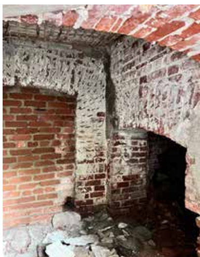
В мае этого года был вскрыт цокольный этаж пастората.
