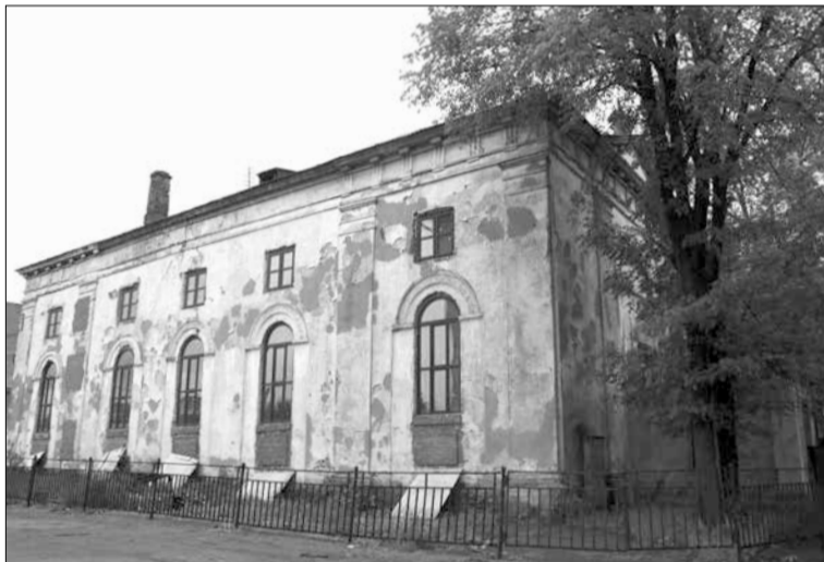
ФАСАД ЗДАНИЯ ЦЕРКВИ ЛЕТОМ 2012 ГОДА
