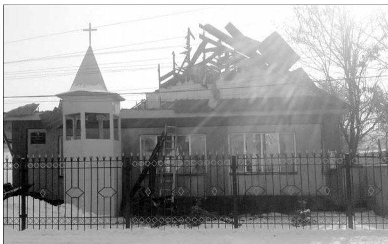
ЗДАНИЕ ЦЕРКВИ В БИШКЕКЕ ПОСЛЕ ПОЖАРА
